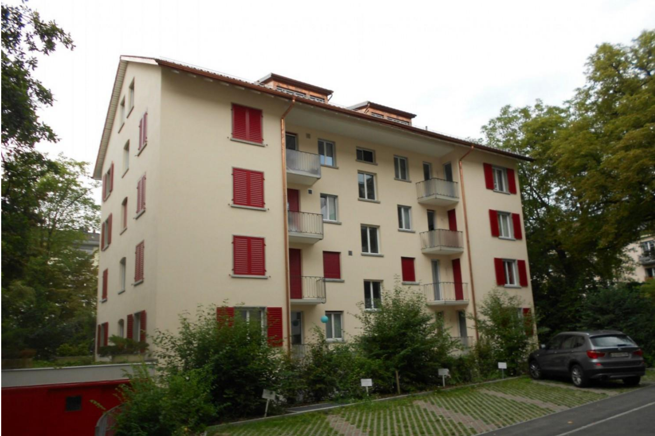
BOLIGBLOKK, SEEFELDSTRASSE ZÜRICH, SVEITS
